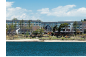
■ホテルアムビエント蓼科ホテル・コンドミニアム
